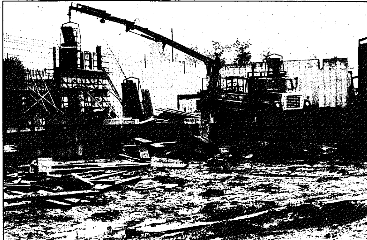
La Laiterie Chagnon de Waterloo investit près de $3 millions dans l'achat d'équipements et l'agrandissement de son usine de Waterloo. Les travaux devraient être complétés au début de l'automne. photo Alain Dion
